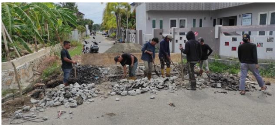
Gambar 6. Pekerjaan Galian Saluran
