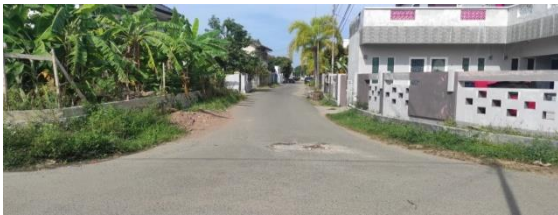
Gambar 5. Foto Lokasi Pekerjaan
