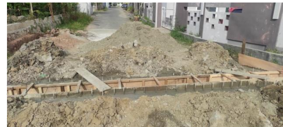
Gambar 9. Pengecoran Dinding Saluran
