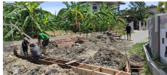
Gambar 8. Pemasangan Bekisting
