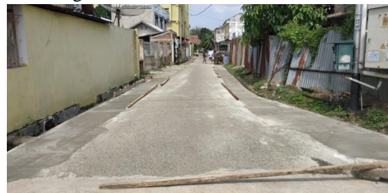
Gambar 7. Hasil Pekerjaan Bahu Jalan
