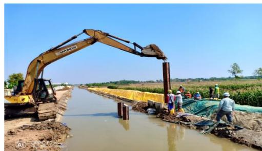
Gambar 2. Pemancangan *Steel Sheet Pile* Proyek Air Baku Klambu-Kudu
